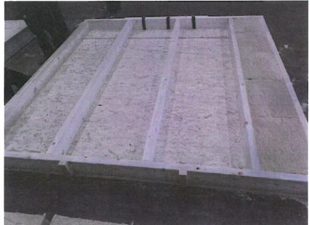
Bild A5.2 Einbringung der Holzfaserdämmplatten.
