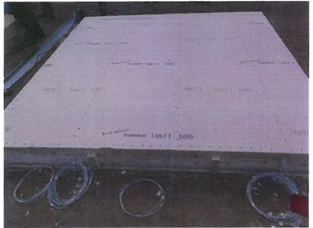
Bild A5.4 Bekleidung/Beplankung der Außenwandseite mit Holzfaserdämmplatten.
