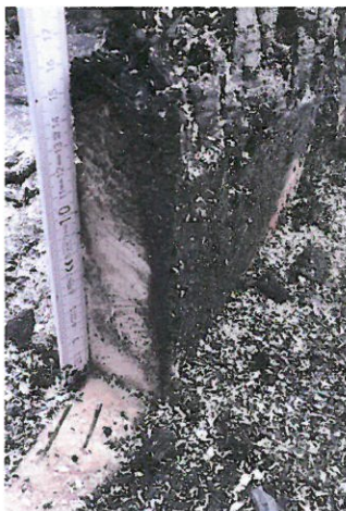
Bild A6.11 Restquerschnitt Ständer 4.
