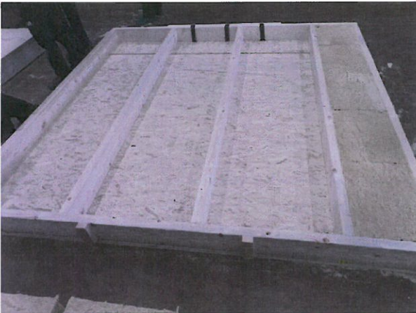
Bild A5.3 Einbringung der Holzfaserdämmplatten.
