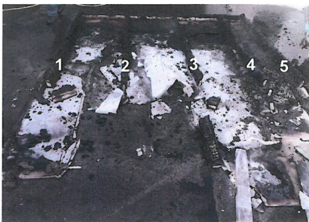
Bild A6.7 Konstruktion nach dem Ausbau und Entfernung der restlichen Dämmung.
