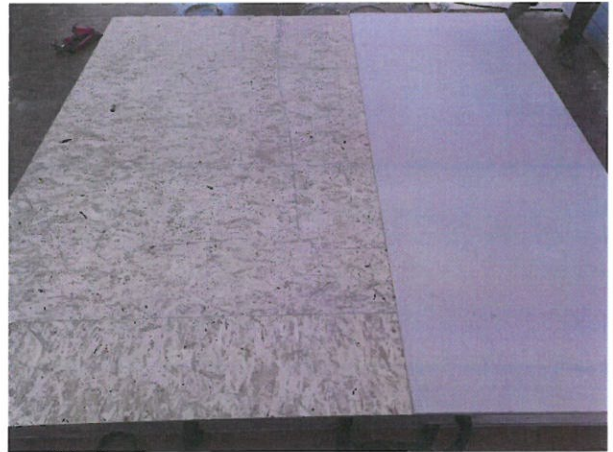
Bild A5.2 Blick von der Rähmseite, Bepunktung mit Feuerschutzplatten auf der Lage aus OSB/4- Platten.
