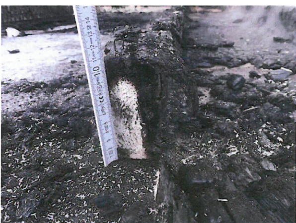
Bild A6.11 Restquerschnitt Ständer 4.
