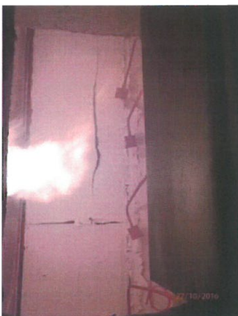
Bild A6.5 Prüfminute 30: Vertikalrisse in Feuerschutzplatten mit schwarzem Grund.
