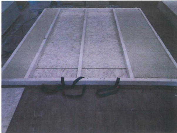
Bild A5.1 Blick auf die Wandkonstruktion von der Rähmseite, Horizontalstoß- Hinterlegung mit Streifen aus OSB/4- Platten.
