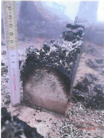
Bild A6.9 Restquerschnitt Ständer 3. Bild A6.10 Restquerschnitt Ständer 4. Bild A6.11 Restquerschnitt Ständer 5.
