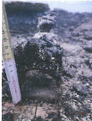
Bild A6.9 Restquerschnitt Ständer 3. Bild A6.10 Restquerschnitt Ständer 4. Bild A6.11 Restquerschnitt Ständer 5.
