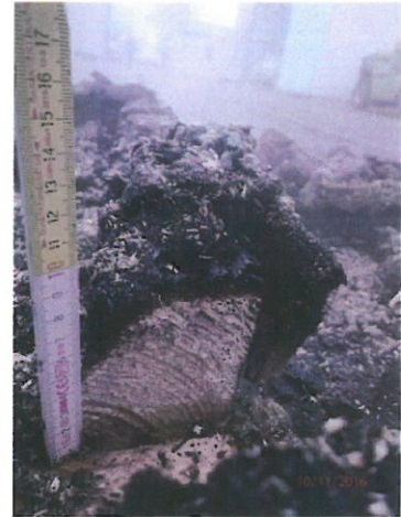
Bild A6.9 Restquerschnitt Ständer 3. Bild A6.10 Restquerschnitt Ständer 4. Bild A6.11 Restquerschnitt Ständer 5.
