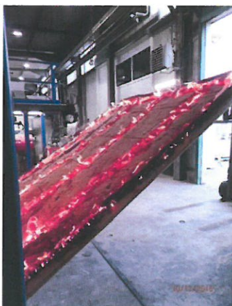
Bild A6.5 Wandkonstruktion nach Beendigung der Feuerwiderstandsprüfung.
