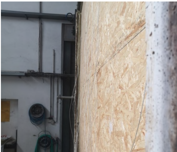
Bild 9: Prüfminute 45 – Sichtbar konvexe Verformung des Probekörpers.
