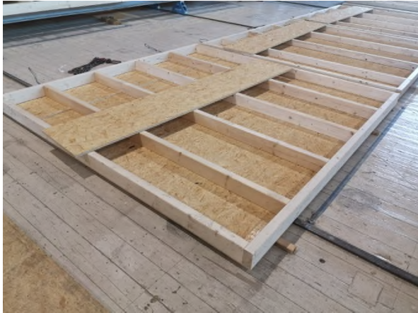
Bild 1 Ansicht der vorbereiteten Tragkonstruktion mit ausgeführter Bekleidungs-/Bepunktungslage von der feuerabgewandten Wandseite.
