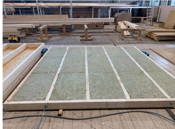
Bild 2 Ansicht auf die eingesetzte Gefachdämmung vor dem Bepunktung/Bekleiden der feuerzugewandten Wandseite.
