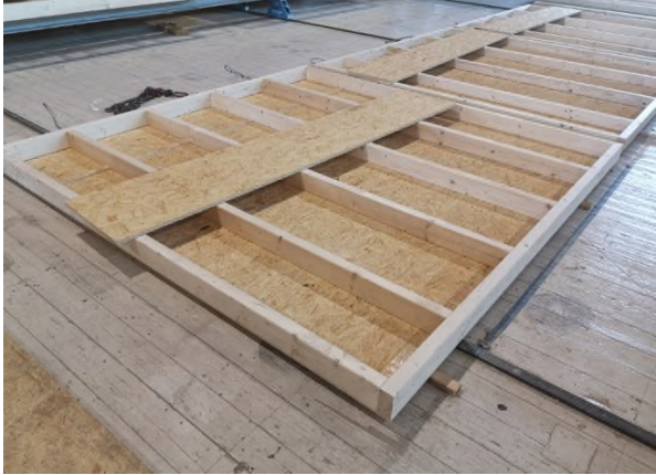
Bild 1 Ansicht der vorbereiteten Tragkonstruktion mit ausgeführter Bekleidungs-/Bepankungslage von der feuerzugewandten Wandseite.
