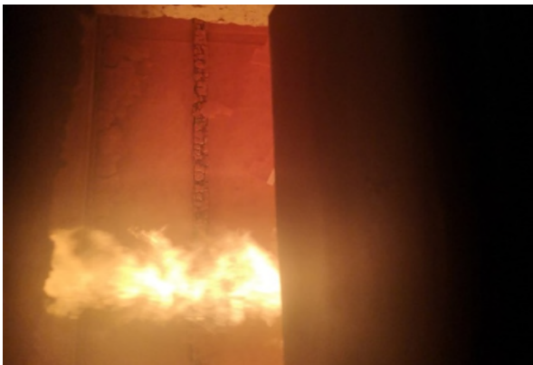
Bild 9: Prüfminute 45 – Beplankungs-/ Bekleidungsfläche vom Ständerwerk abgefallen. Gefachdämmstoff vollständig freigelegt.
