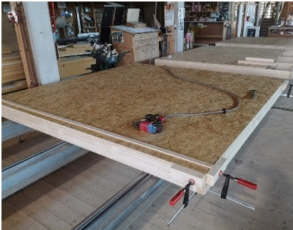
Bild 3 Ansicht auf die vorbereitete Bekleidungs-/Bepankungslage der feuerzugewandten Wandseite.
