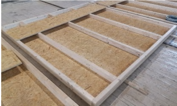
Bild 1 Ansicht der vorbereiteten Tragkonstruktion mit ausgeführter Bekleidungs-/Beplankungslage von der feuerabgewandten Wandseite.
