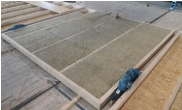
Bild 3 Ansicht auf die eingesetzte Gefachdämmung vor dem Beplanen/Bekleiden der feuerzugewandten Wandseite.
