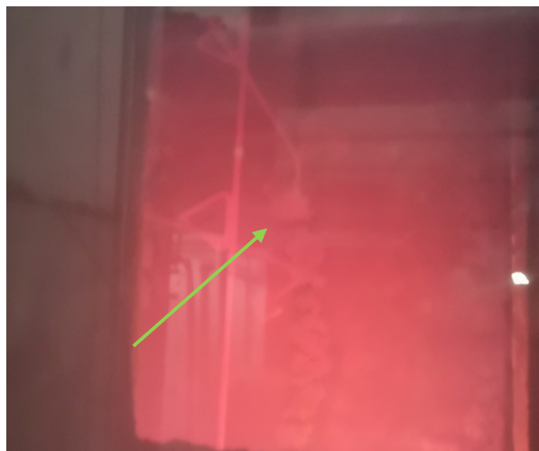
Bild 8: Prüfminute 20 – Sichtprüfung wieder eingeschränkt möglich. Beplankungs-/Bekleidungsfläche fast vollständig verbrannt, Restsegmente der Plattenlage nur noch an den Ständern erkennbar. Gefachdämmstoff vollständig freigelegt jedoch nicht ausgefallen.
