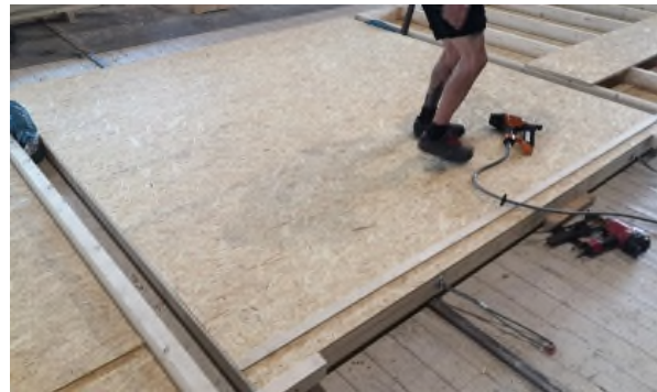
Bild 4 Ansicht auf die vollständig montierte feuerzugewandte Beplankungs-/Bekleidungs-lage.
