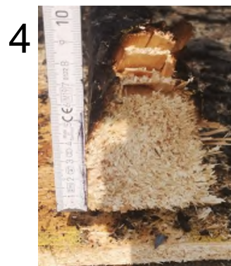
Bild 14 Restquerschnitt am vierten Ständer (ca. 70 mm)
