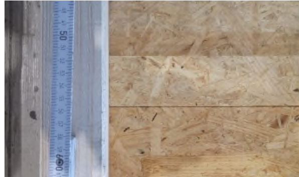
Bild 2 Detailansicht der Hinterlegung auf der feuerabgewandten Beplankungs-/Bekleidungs-lage, vor der Montage der Gefachdämmung.
