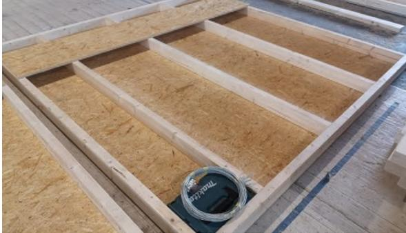
**Bild 1** Ansicht der vorbereiteten Tragkonstruktion mit ausgeführter Bekleidungs-/Beplankungslage von der feuerzugewandten Wandseite.
