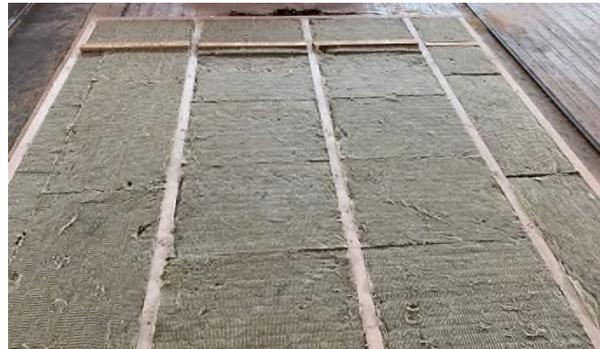
**Bild 4** Ansicht auf die eingesetzte Gefachdämmung vor dem Beplanken/Bekleiden der feuerzugewandten Wandseite.
